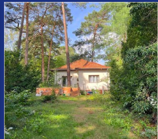
BAUGRUNDSTÜCK MIT ABRISS BERLIN-FROHNAU
